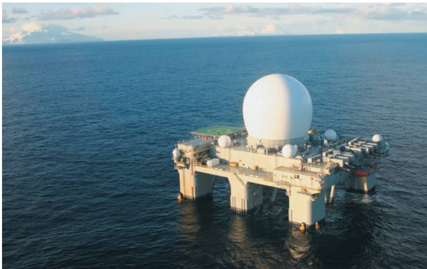
Estación de radar marítima de banda X en la zona de las islas Aleutianas. Fotografía cedida por la Agencia de Defensa Antimisiles ( http://www.mda.mil/global/images/system/sbx/img_2845.jpg )
